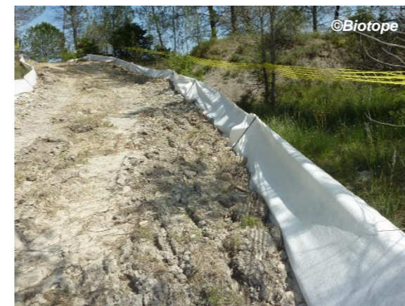
Figure 79 : Exemple de mise en exclos d'un site dans le cadre d'un chantier de creusement de tranchées (BIOTOPE, 2016).
